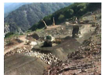
建設機械作業状況
